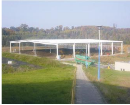
Μονάδα Κομποστοποίησης στη Γερμανία
